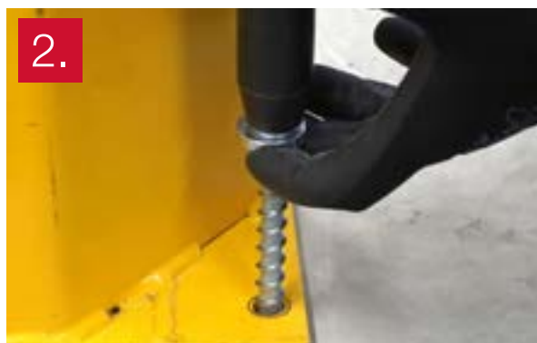
2. Skruva in betongskruven med fyllnadsbrickan mot fixturen som ska fixeras.
